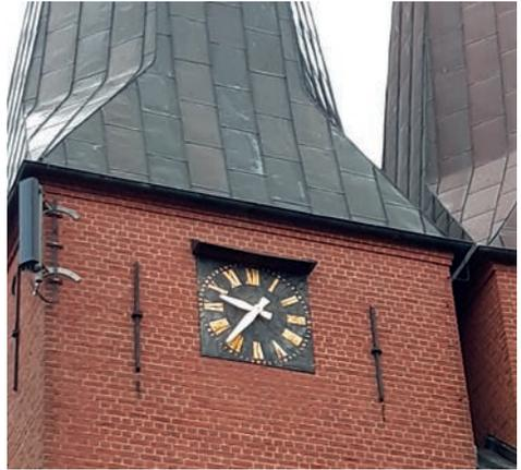
Als alles vorbereitet war, die Ersatzteile beschafft und die Zeiger aufgefrischt waren, ging es an die Reparatur vor Ort. Das war kein leichtes Unterfangen, denn die Zeiger werden durch eine Gewindestange bewegt, die durch ein schmales Rohr durch die dicken Mauern des Kirchturms führt. Jürgen Söhle und der Monteur der Firma Iversen sind bestimmt zehn Mal die vielen Treppen nach oben in den Kirchturm gestiegen, bis alle Reparaturarbeiten ausgeführt waren.
